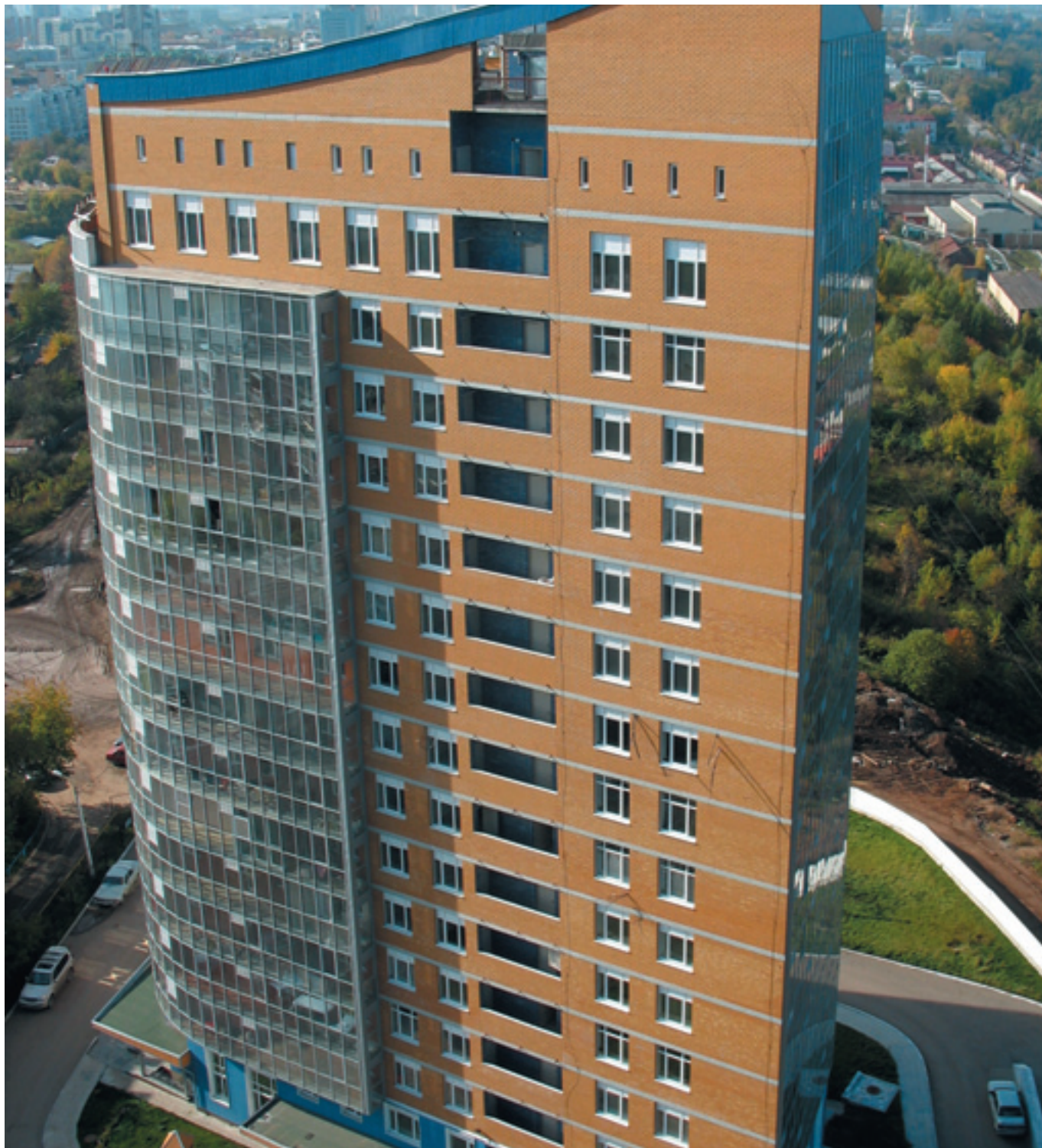
Жилой комплекс "Паруса над Камой", г. Пермь
