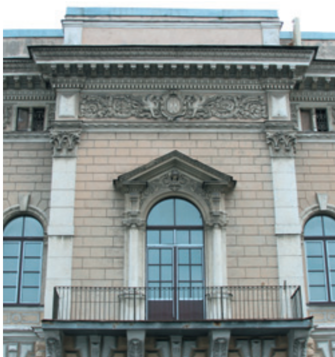
Историческое здание, г. Москва
