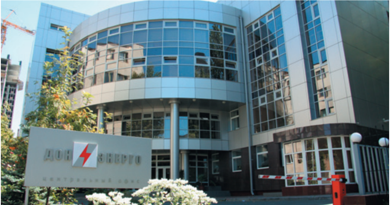
Здание ЗАО "Донстройэнерго", г. Ростов-на-Дону
