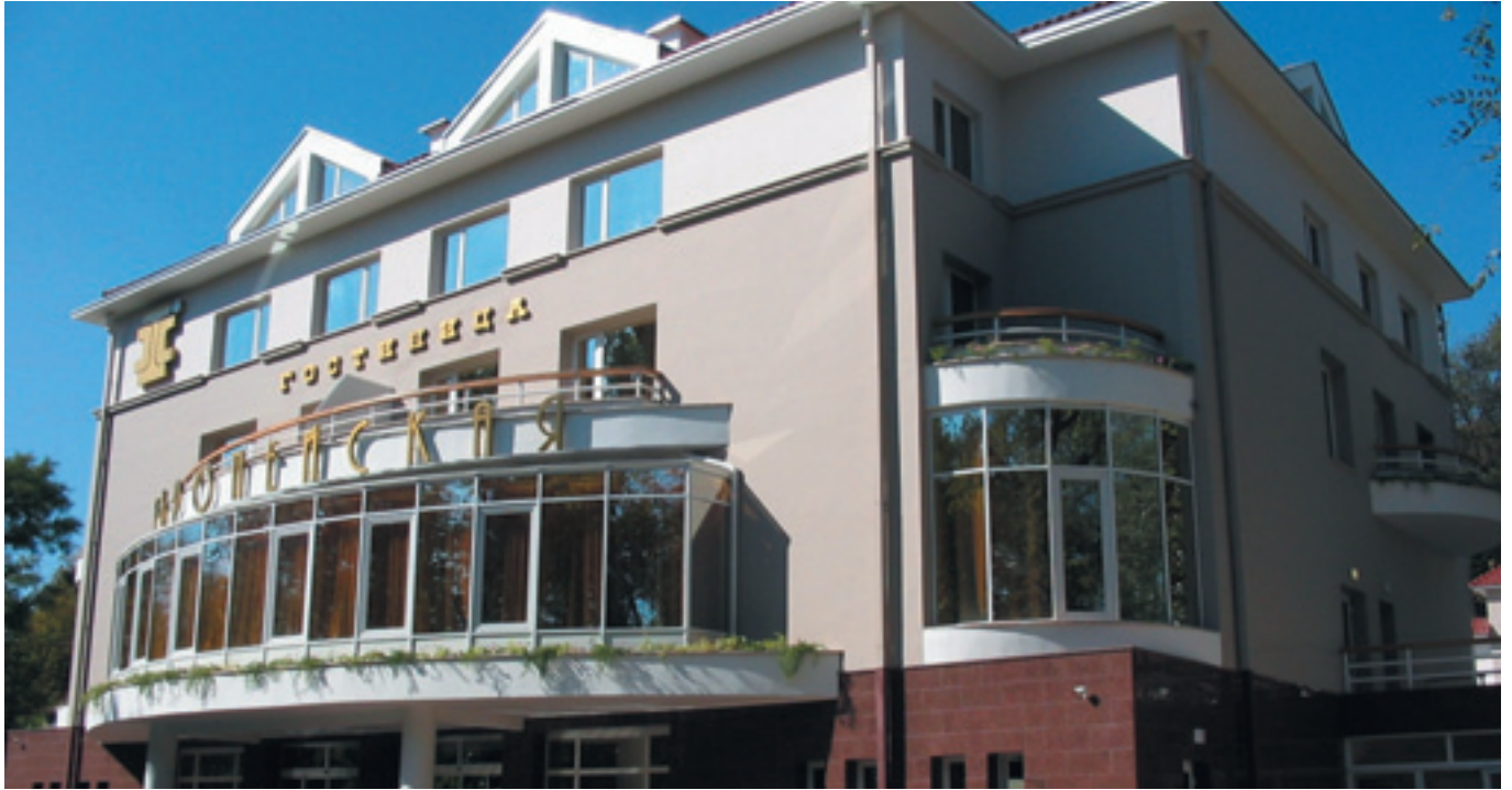
Здание гостиницы, г. Мариуполь
