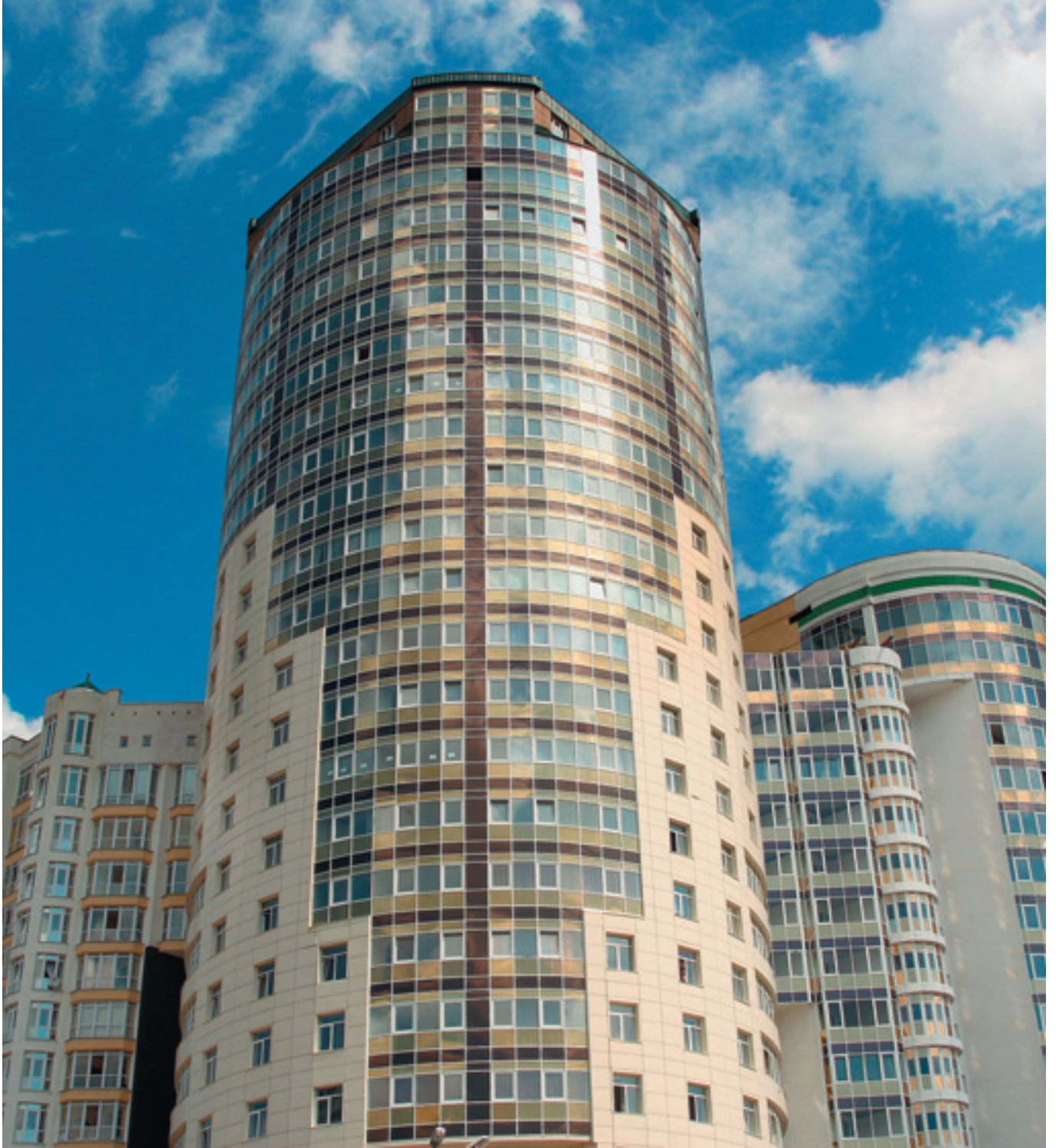
Жилой дом "Кольцо Екатерины", г. Екатеринбург
